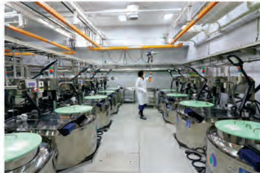
バイオバンク・ジャパンの血清保管庫 マイナス150℃を維持したタンク内に約300万本の血清・生膜の保管が可能です。
